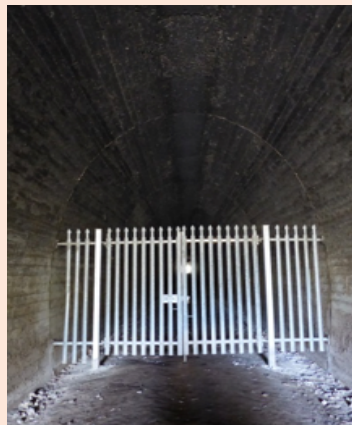
Зүүн Өмнөд Квинслэндэд байдаг Мунтана туннел, түүний доод хэсгийг хүн оруулахгүйн тулд хаашаажуулсан байна.
